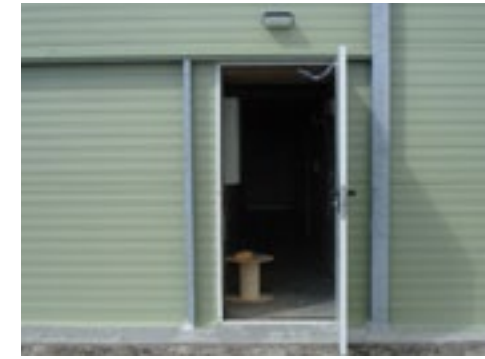
▲ Een PL-lamp boven een deur geeft met een licht-donkerschakelaar goed oriëntatielicht.
