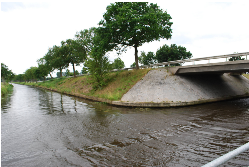
Brug N353 Oldeberkoperweg: vaart richting het zuidoosten.
