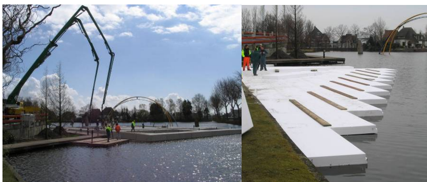
Bouw Demo Drijvende Kas
