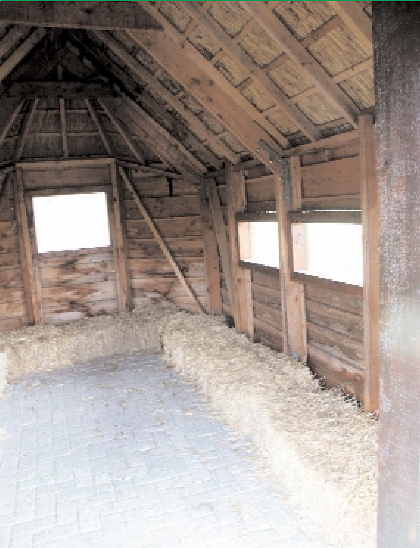
De schaapskooi is heel toepasselijk met riet gedekt en heeft een interieur van pakken stro.
