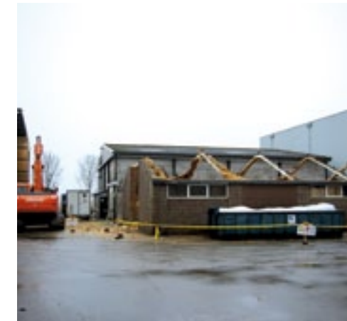
▲ Een van de uitvoeringseisen is een afzettingslint rondom de bouw.
