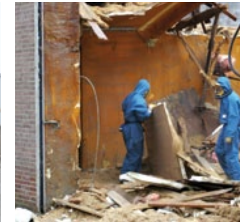
▲ Slopen is door gecertificeerd personeel in beschermende kleding met persgasmaskers.
