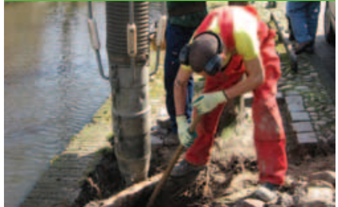
foto 5 Bewortelingsonderzoek aan de historische kademuur van De Havik in Amersfoort.
