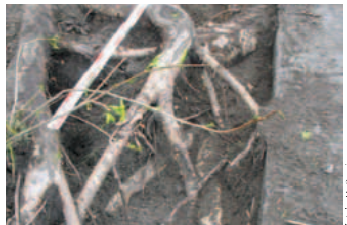
foto 3 De situatie langs de kademuur
