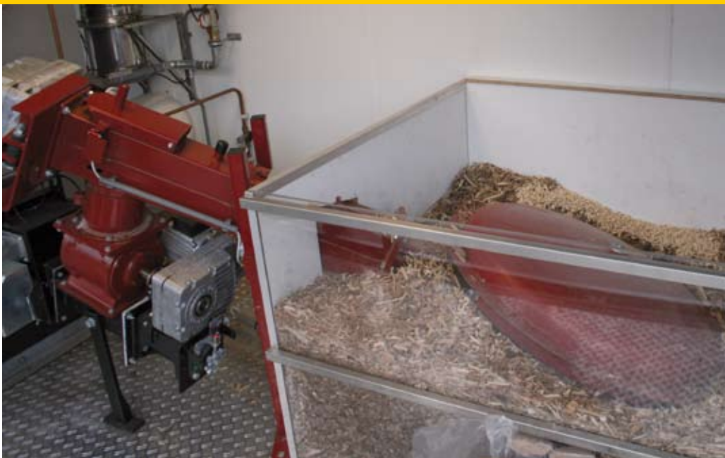
Toevoersysteem zorgt voor de regelmatige aanvoer van houtsnippers/houtchips (foto: Degin BV).
