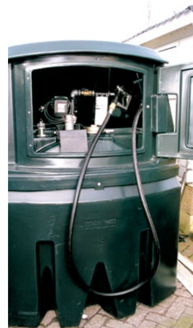
▲ Per 1 juni 2011 moet de brandstoftank volledig zijn afgeschermd, inclusief de pompinstallatie. Elke bovengrondse brandstoftank moet dubbelwandig zijn of enkelwandig geplaatst in een lekbak, beide voorzien van een KIWA-certificaat.
