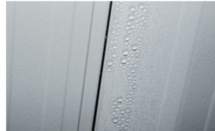
▲ Deze naad zit niet goed dicht. Alleen bij de naad zit condens.
