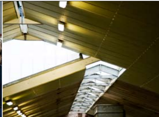
Geïsoleerd dak zonder lichtplaten
