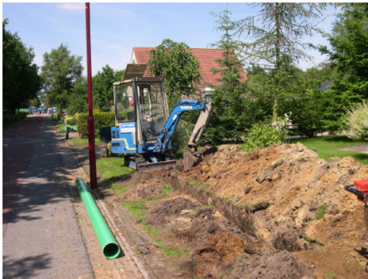
Figuur 3-6: Graafwerkzaamheden voor het afkoppelen van regenwater (uit: Claassen 2006).
