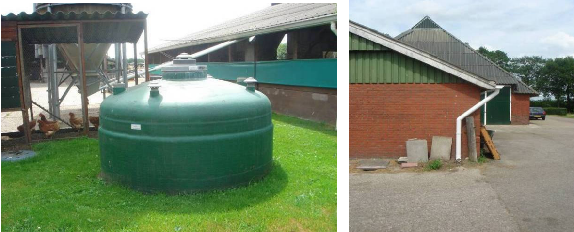
Figuur 3-5: Links IBA tank op boerenbedrijf 't Oerset te Eastermar,, rechts nieuwe dakgoten en regenpijpen voor de afvoer van schoon regenwater naar een droge berm-sloot zomer 2010 (foto's: Grontmij).
