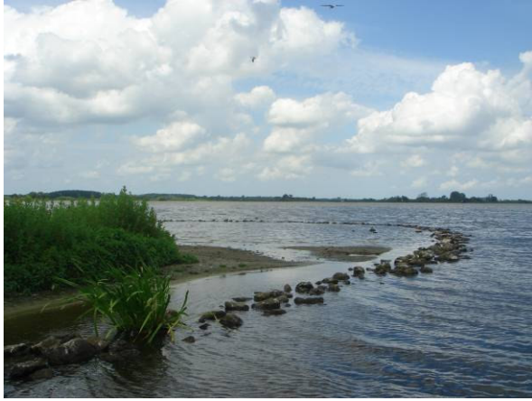
Figuur 3-9: Twee typen eilandjes in de Leijen, rechts met aanleg mogelijkheid en links met breukstenen vooroeverdam (foto's: Grontmij).
