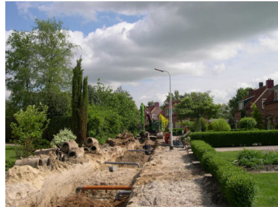
Figuur 3-6: Graafwerkzaamheden voor het afkoppelen van regenwater (uit: Claassen 2006).
