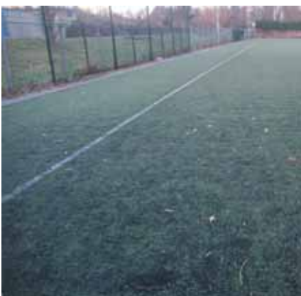
Een mix van gefibrilleerd en monofilament uit 2004
