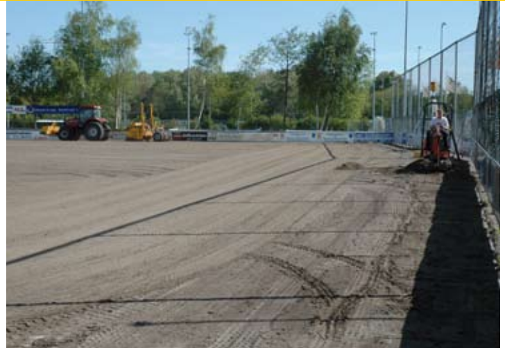
Groot onderhoud besteedt de gemeente uit. Ook hier een toprenovatie op Sportpark Kastelenring. Het veld is omgespit en de doelmonden zijn van zeoliet voorzien.
