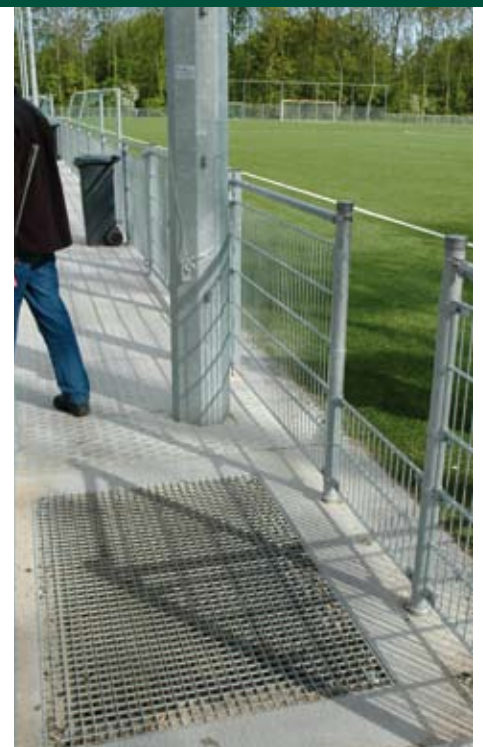
Uniformering van het dubbelstaafs hekwerk op alle complexen.
