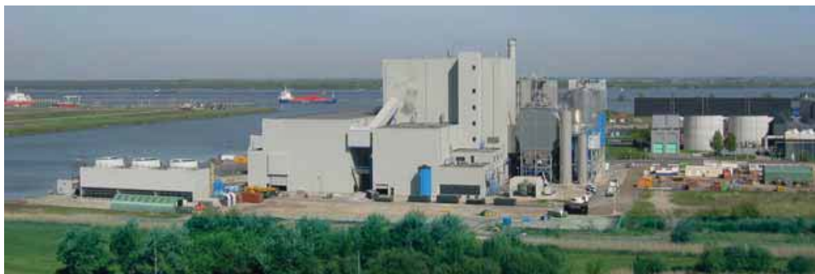
De mestverwerkingsinstallatie in Moerdijk verwerkt jaarlijks 440 duizend ton mest van kippen en kalkoenen.
