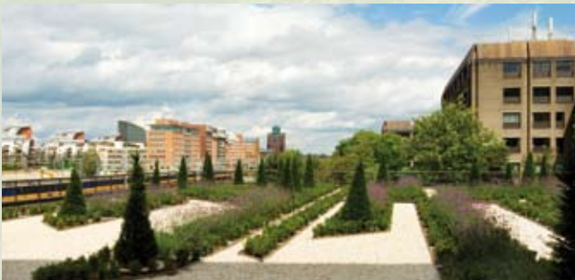
Printplaattuin op nieuwbouwvleugel.
