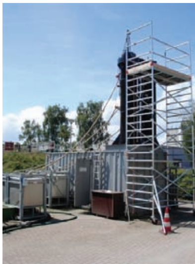
AFBEELDING 4 FOTO EN PROCESSHEMA PILOTINSTALLATIE OP RWZI EPE
