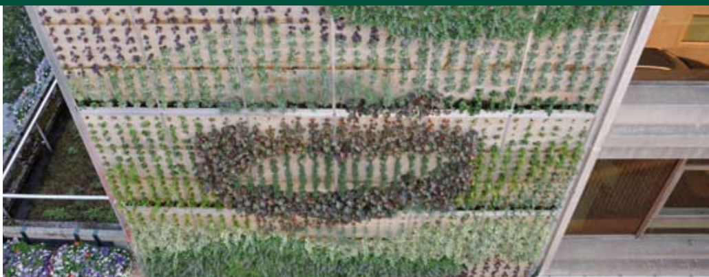
Livepanel systeem in Hasselt België volledig gesloten systeem, 4 weken na aanplant met pluggen vanuit 104 gaats tray
