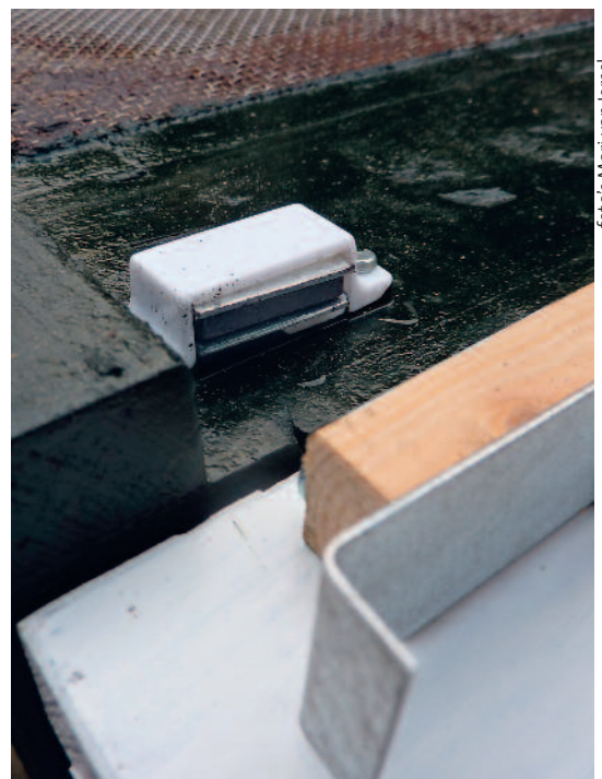
Detail van magneetsnapslot aan afsluitlat
