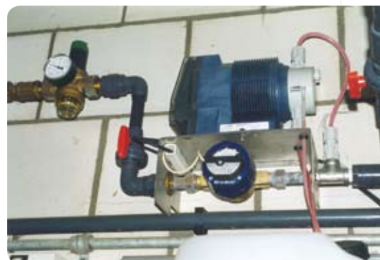
Dosator: systeem waarmee drinkwatermedicatie wordt toegepast. Pijnstillers via het drinkwater toedienen is mogelijk c.q. toegestaan.
