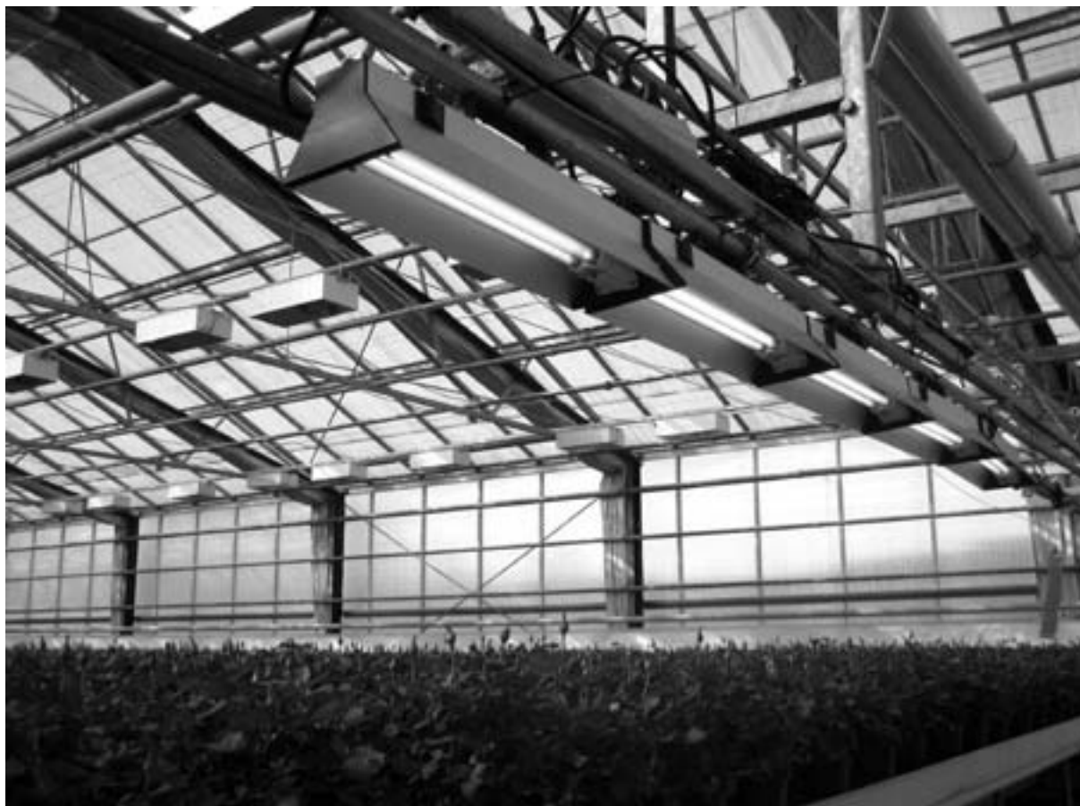
Figuur 1. UV-lampen op spuitbomen bij potplanten (roos) in Denemarken.
