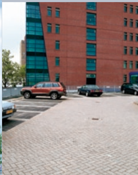
Het Eneco-gebouw in Den Haag, onderwerp van onderzoek
