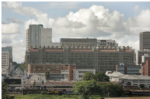
Het gebouw van Eastgate Centre, herkenbaar aan de schoorstenen. (source: Wikipedia/Mick Pearce)
