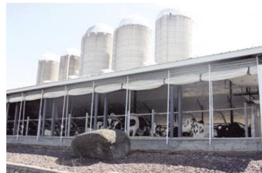
Goede klimaatbeheersing noodzakelijk door extreme temperatuurverschillen in Quebec
