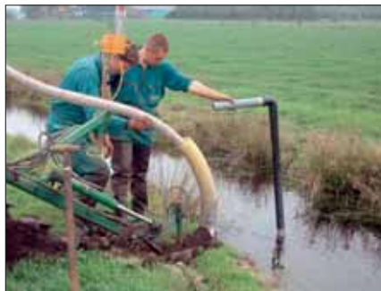
Met een klein formaat draineermachine is buisdrainage met een kunststofomhulling in de grond gebracht
