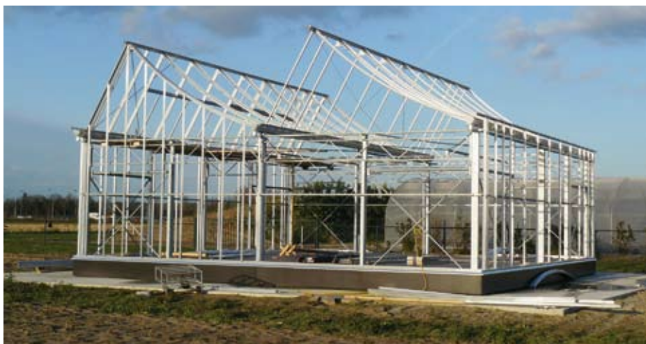
Het prototype van de elektriciteitleverende kas (ELKAS) is in Wageningen in aanbouw.
