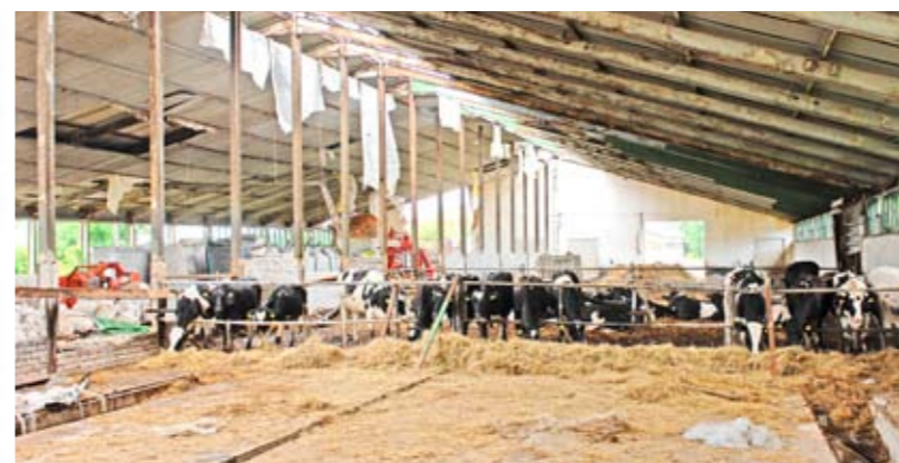
Een van de stallen voor de renovatie
