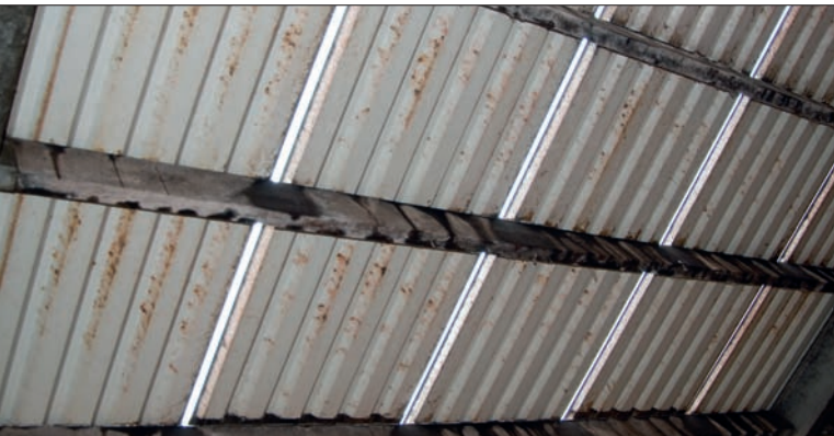
Dakplaten liggen 13 mm uit elkaar voor extra ventilatie
