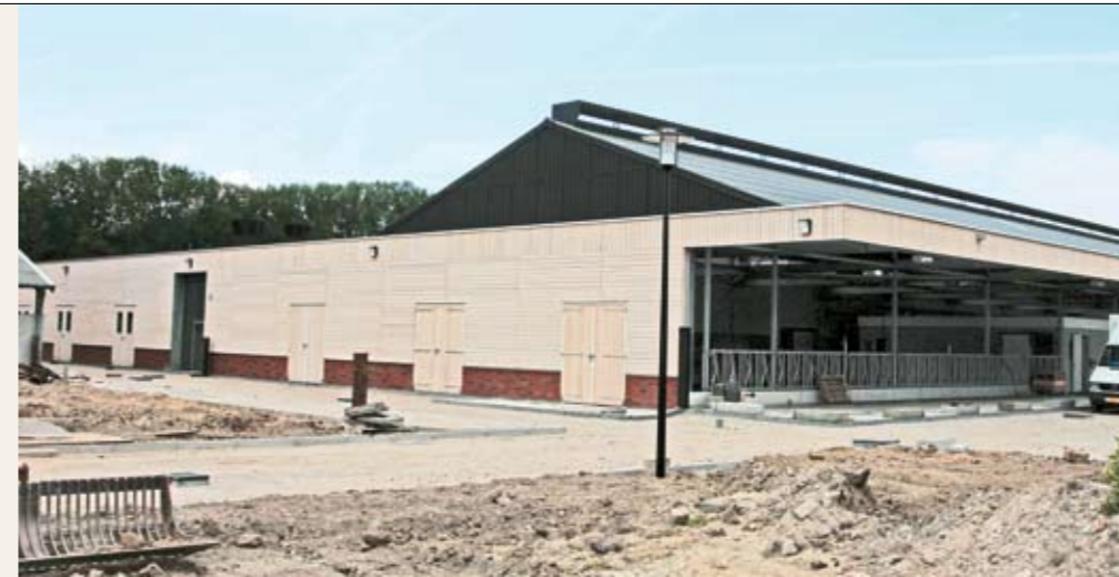
De openfrontstal is in de lijn van het gebouw geplaatst
