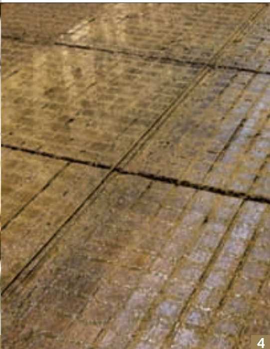
4 Plusvloer met om de 1,20 meter een mestsleuf
