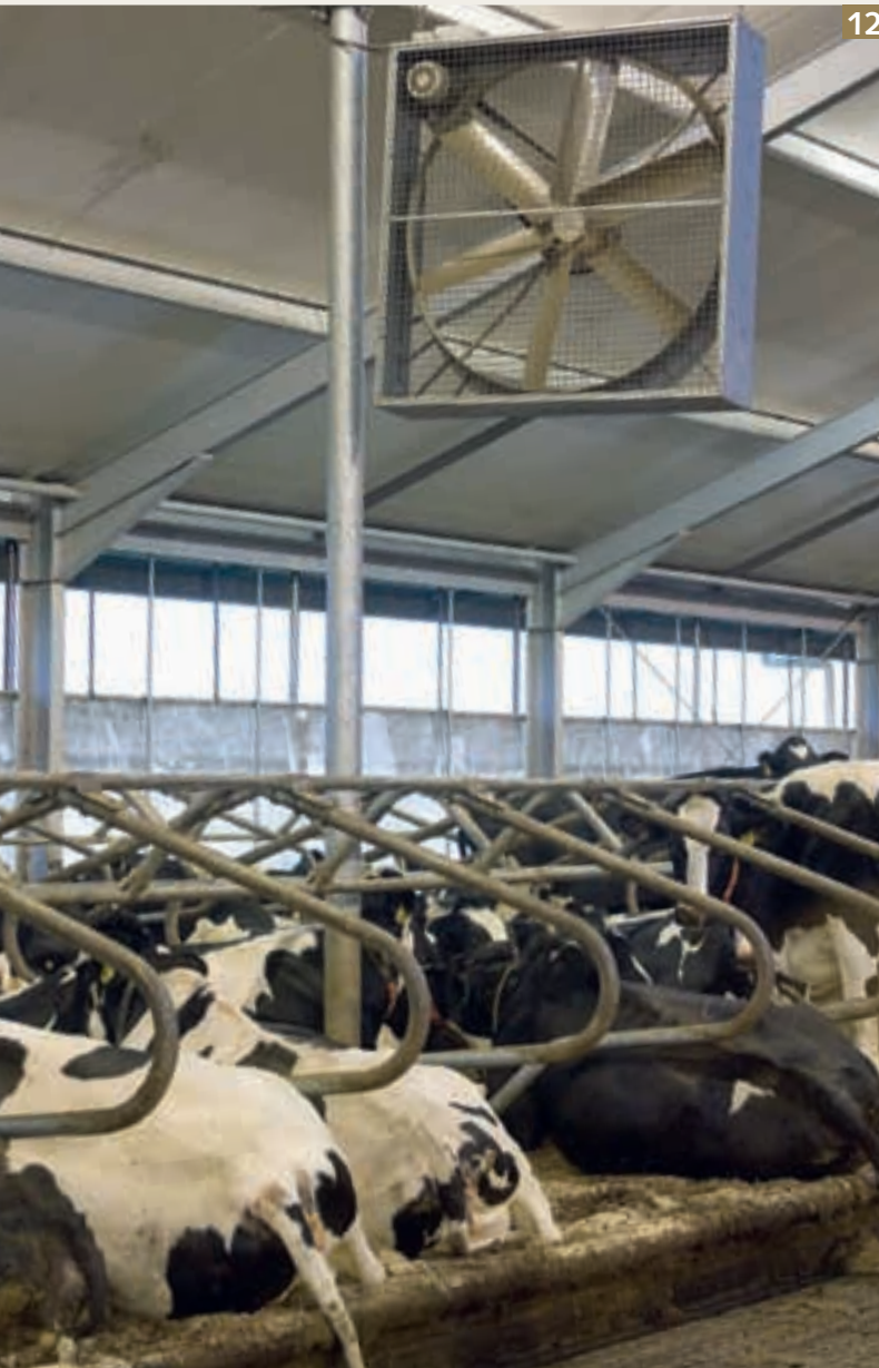
Een geïsoleerd dak en ventilatoren voor koecomfort bij warme dagen
