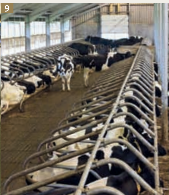
9 De ligboxen staan op een afstand van 1,10 meter
