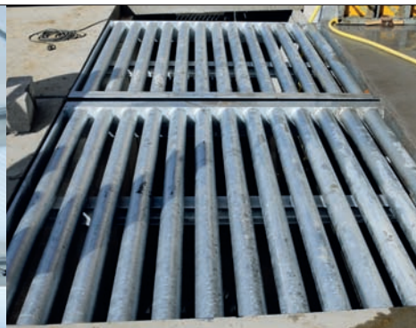
Scheiding mest en zand in bezinkbakken
