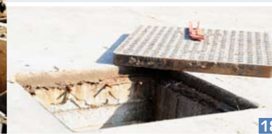
Onder het erf ligt een enorm bassin dat dient voor de opvang van regenwater
