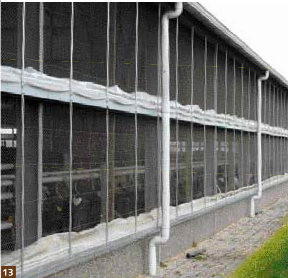
Opblaasbaar windscherm eenvoudig in twee delen op te laten. Vogelgaas weert spreuwen en mussen
