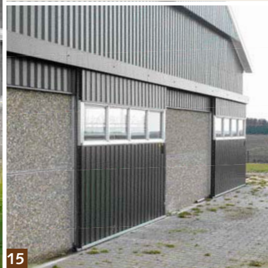
Extra schuifdeuren voor extra ventilatie vergroten tevens bereikbaarheid ligboxen
