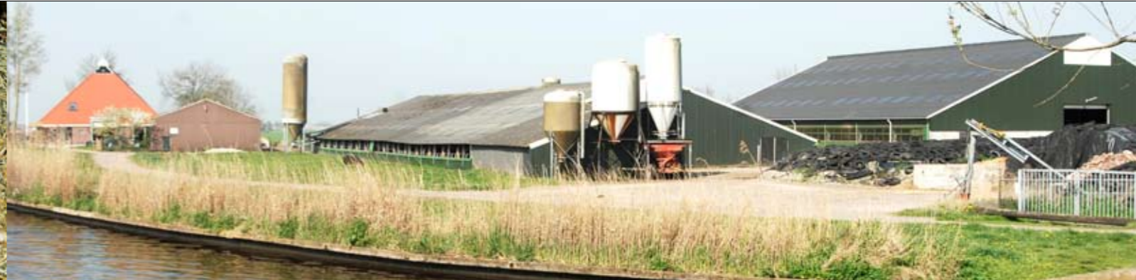
Bedrijfsverzicht met rechts de uitbreiding van de ligboxenstal (met 168 ligplaatsen)
