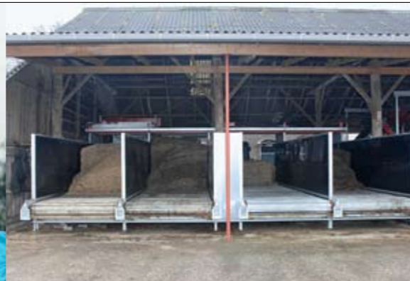
De voorraadbunkers staan in een oude werktuigberging
