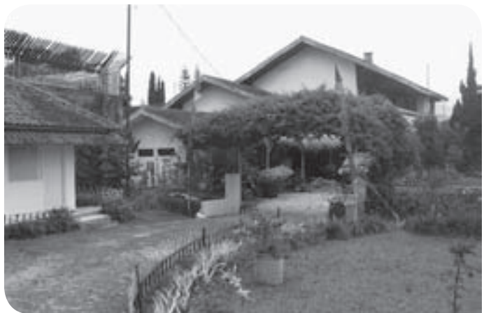
Zicht op het restaurant vanaf de oprit. Links de Europees ingerichte toilet met wasgelegenheid.
