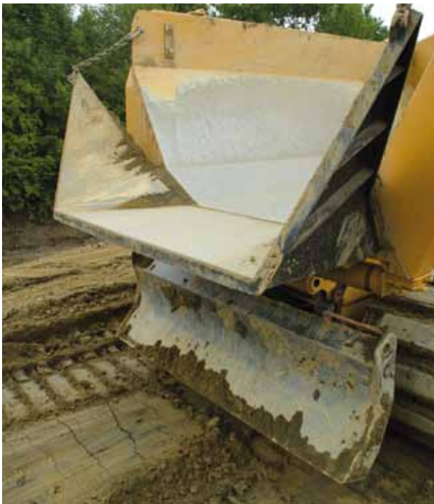
◀ Achteruit het talud op, met de doseerlepel en het dozerblad het materiaal verdelen en verdichten met de rupsen.
