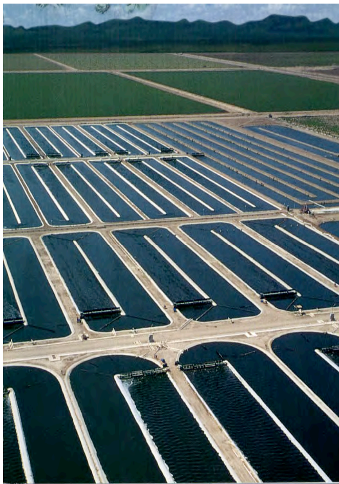
Figuur 2 Typen fotobioreactoren voor micro-algenteelt. Links: High Rate Algal Ponds, Earth Rise Farms, Californië, USA. Rechtsboven: Semi-gesloten fotobioreactor IGV, Potsdam, Duitsland. Rechtsonder: Pilot schaal cascade systeem ontwikkeld door ECN, UvA en IVAM [4].
