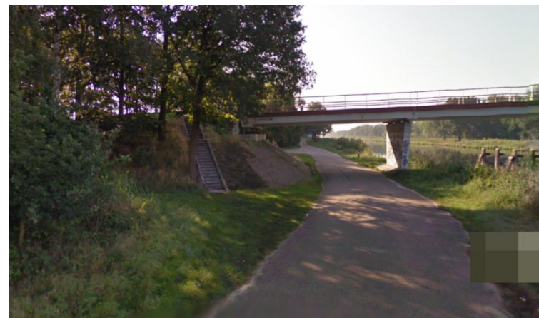
Figuur 9.4 Entree naar de natuurbrug vanaf Kanaalweg (Bron: GoogleMaps)
