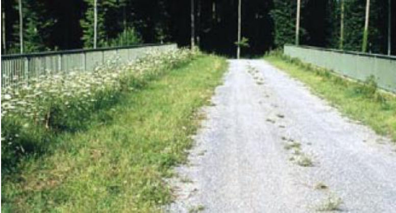
Figuur 7.8 Faunavoorziening over bestaande brug (Mauritskamp, Utrecht)
