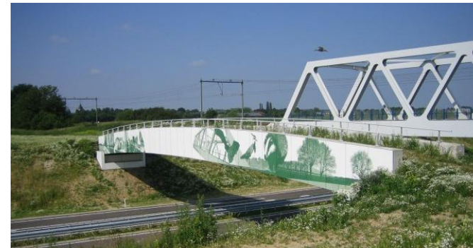
Figuur 7.11 Faunavoorziening aan de bestaande brug
