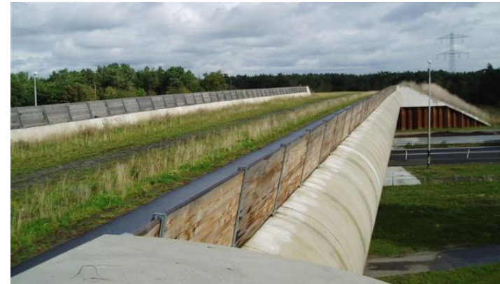
Figuur 7.10 Faunavoorziening aan de bestaande brug
