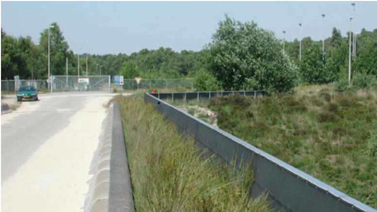
Figuur 7.9 Faunavoorziening over bestaande brug (Duitsland)
