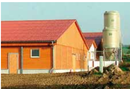
Ander type stallen, zoals ronde stallen en houten stallen, zijn in Duitsland, Scandinavië en Oostenrijk heel gebruikelijk. Europees hout is 15 keer minder milieubelastend dan kunststof. Foto: DROTT Holzbau
