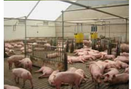
Boogstallen met minder muren en minder materiaal voor dakbedekking, kan een varkenshouder 9 tot 16% op de bouwkosten besparen. Foto: Booghal BV
