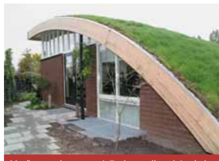
Ideeën voor duurzame stallenbouw zijn ook te vinden in andere sectoren; een recreatiewoning met gelijmd houten spanten en een grasdak. Foto: Groendak
