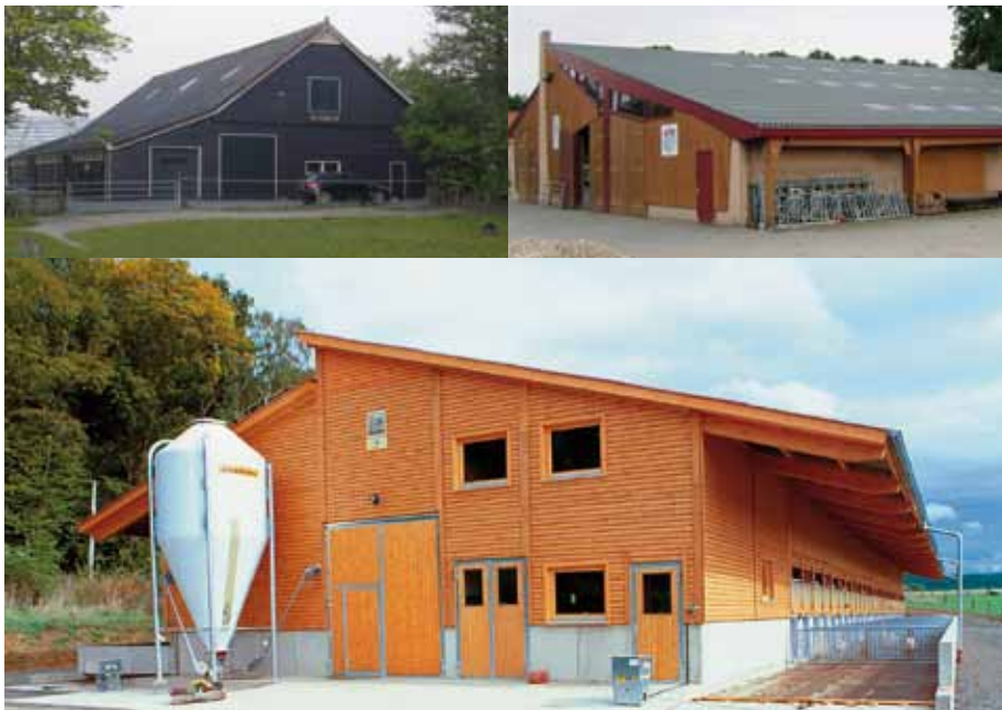
Foto's boven: Herkenbaar biologisch. Foto onder: DROTT Holzbau
