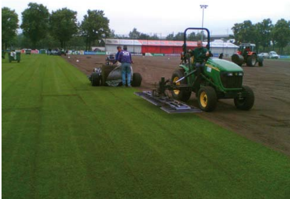
De 'herbezodingsmachine' betreft een combi-trekker met hydraulische grid die pennen in de zoden zet voor grip en de zode dan tegen de voorgaande zode aantrekt. De machine is door de jaren heen verder ontwikkeld.
