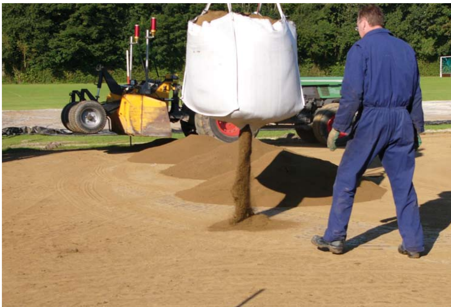
Het aanbrengen van Binders Loam als toplaag.
