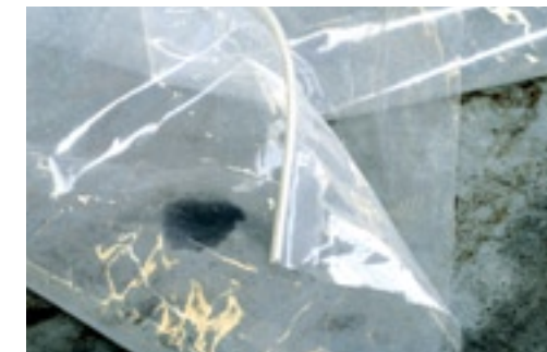
In de folie zit een pees. Aan de nokzijde wordt die door een aluminium profiel getrokken.
