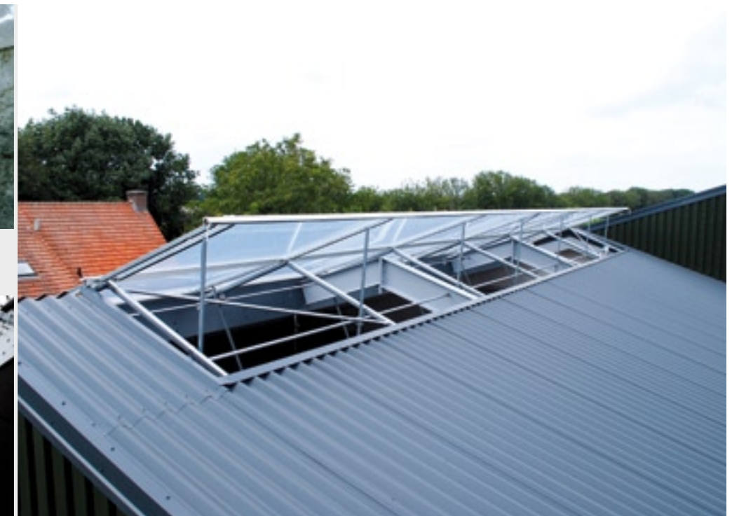
De nok kan aan twee zijden open. Een automatische regeling door middel van een weerstation inclusief computer kost ongeveer 2.000 euro extra.
