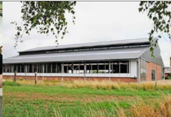
Dubbel dak garandeert voldoende dwarsverluchting
