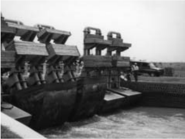
Streven naar eenvoudige oplossingen; zelfregulerende stuwdeuren
