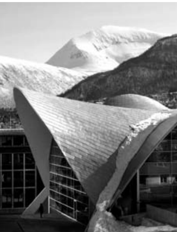
Stadhuis en bibliotheek. In de constructie houdt men rekening met een minimale sneeuwlast. (Foto: Tord Kvien)
