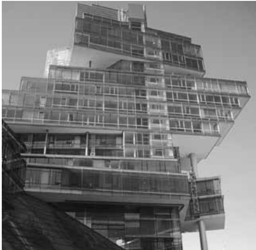
Figure 5. Hoe complexer de constructie, hoe langer dat men bouwen moet. Ook een bank heeft niet het eeuwig leven. Norddeutsche Landesbank te Hannover.
