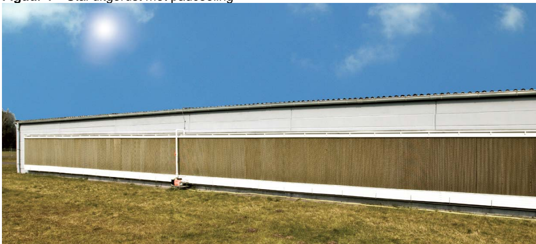
Figuur 1 Stal uitgerust met padcooling
