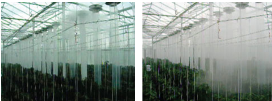
Figuur 12. Eerste foto: Begin van rookproef met zicht boven op het gewas. Rook is ingebracht bij de aanzuigmond van de koeling (te zien aan de rechter kant) en komt boven uit het verdeelstuk, waar het boven in de kas in een wolk kort blijft hangen. Tweede foto: Vervolg van rookproef met zicht boven op het gewas. De meerderheid van de rook valt direct naar beneden in het pad meteen naast de koeling. Relatief weinig rook viel in het pad daarnaast (tweede pad vanaf de koeling, te zien aan de rechter kant).
