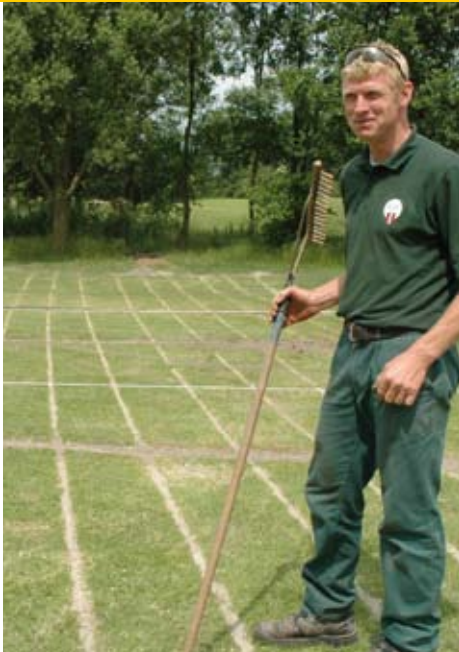
Drainagesleuven op hoofdsysteem
