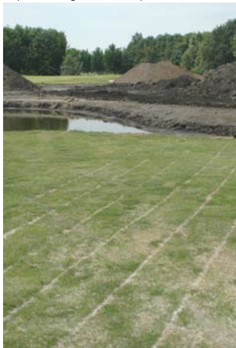
Aanleg van een nieuwe waterpartij
