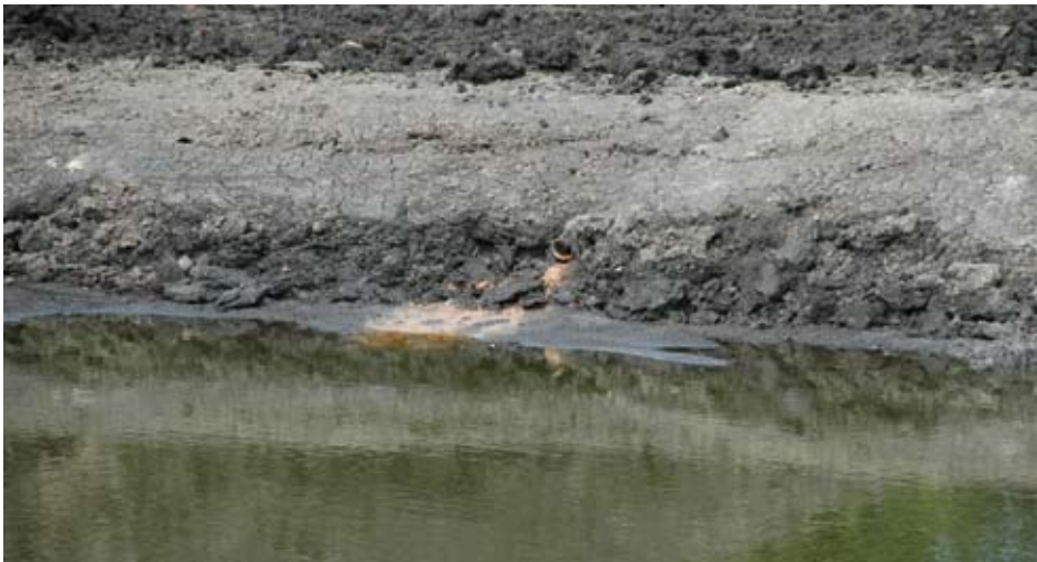
Berkhout moet de drainagepijpen vaak doorspuiten, omdat die de grondstof ijzer in zich hebben dat uit de grond naar beneden sijpelt.
