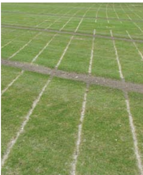
Theo Berkhout: "De zandsleuven leiden het water naar de hoofddrain, omdat het de weg van de minste weerstand zoekt. Zo staan alle afvoerleidingen met elkaar in verbinding. Water op de baan vindt zo razendsnel zijn weg naar de sloot. Op zware klei is dit de enige manier."
