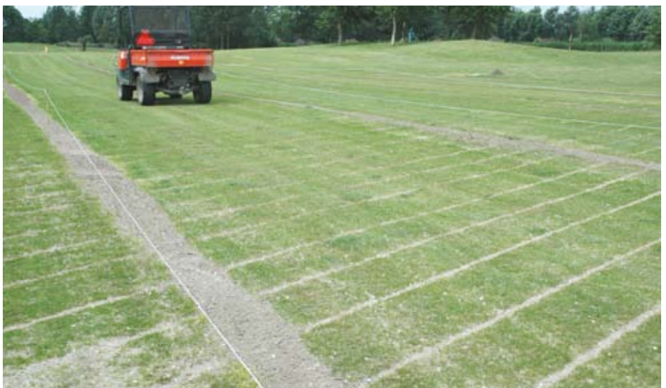
Theo Berkhout: "De topdrainer brengt het zand echt met hoge druk in de sleuf aan. Dan krijg je een harde compacte zandsleuf. Het whizz-wheel laat het zand gewoon vallen. De sleuf bij de topdrain blijft compact."
