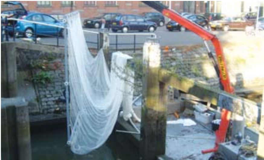
Fig 9 PLAATSING VAN EEN FRAME MET OPVANGFUIK BIJ GEMAAL SCHILTHUIS
