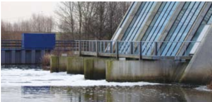
Fig 6 GEMAAL OVERWAARD (VIJZEL) IN ACTIE
